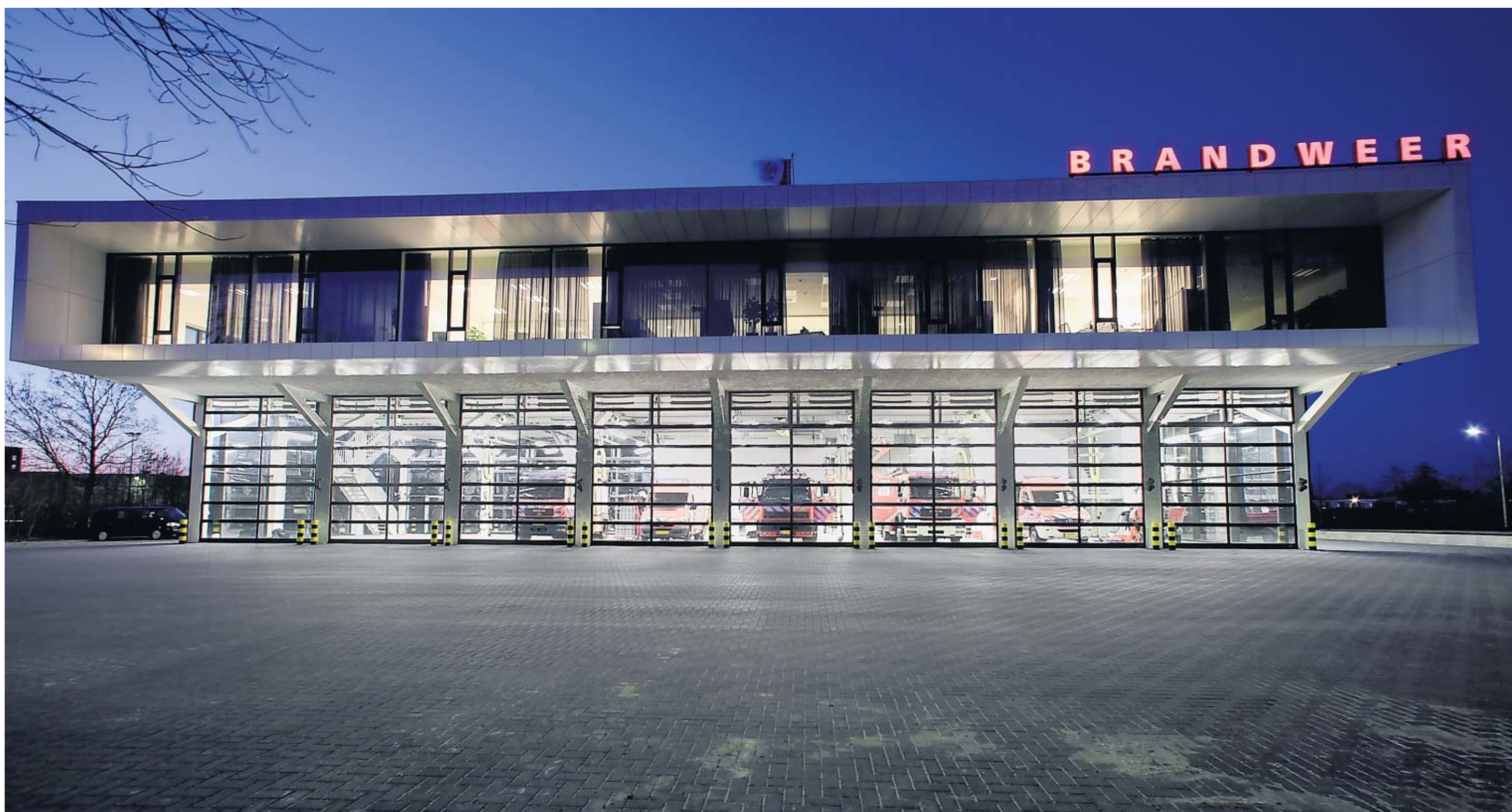
De nieuwe brandweerkazerne telt in totaal dertien uitrijdeuren. Hier het aanzicht van de acht deuren voor de eerstelijnsuitruk. Die zijn zo breed dat er veel ruimte zit tussen de geparkeerde voertuigen, wat de veiligheid van het personeel ten goede komt.
