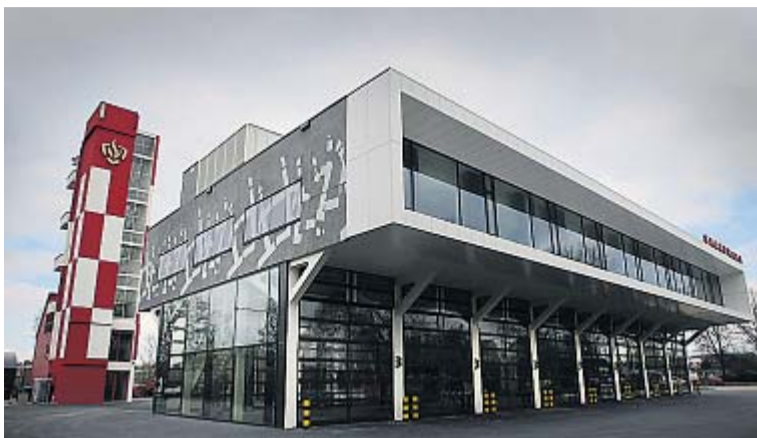
De nieuwbouw van de brandweer.
