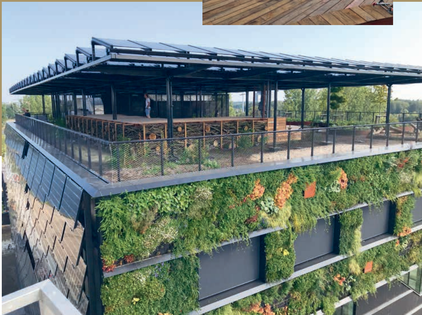
Alle functies op het dak van Aeres Hogeschool Almere: groen, blauw, geel en rood. Links op het dak is de takkenrail voor insecten zichtbaar. (Foto: Aannemingsmaatschappij Hegeman)
